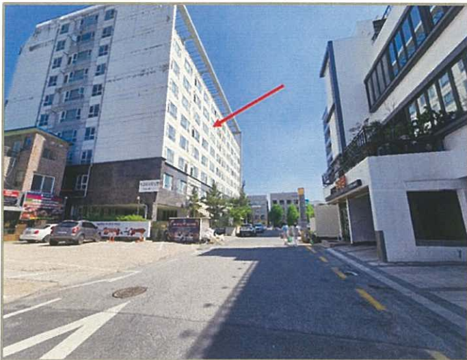
주위 전경 - 북서측에서 촬영
